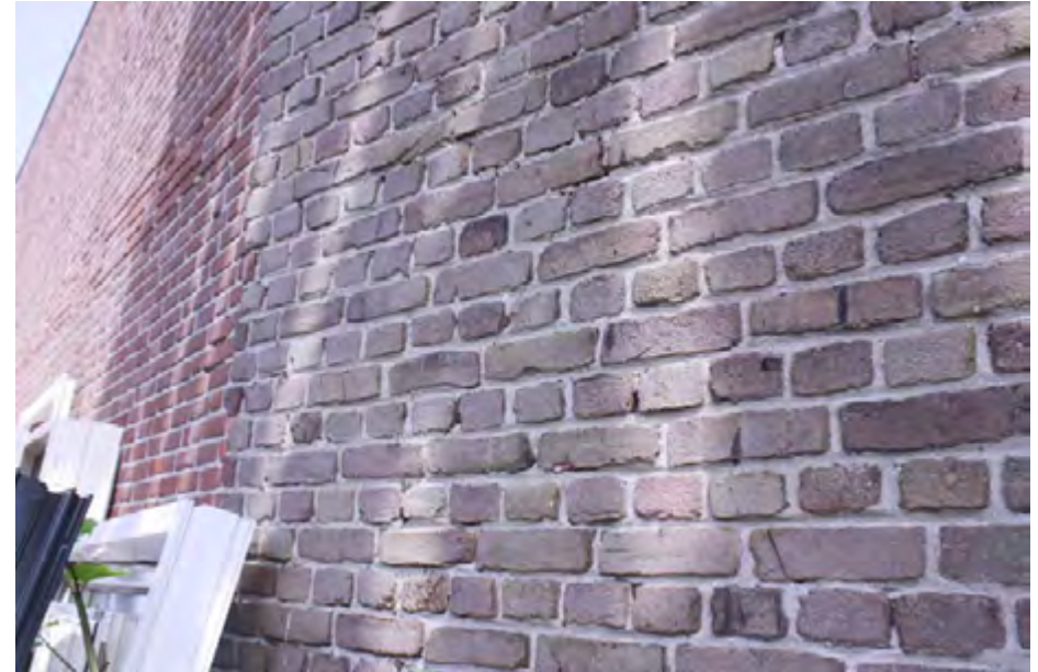
Zicht op de aansluiting van het muurwerk uit 1928 op dat van 1962.
