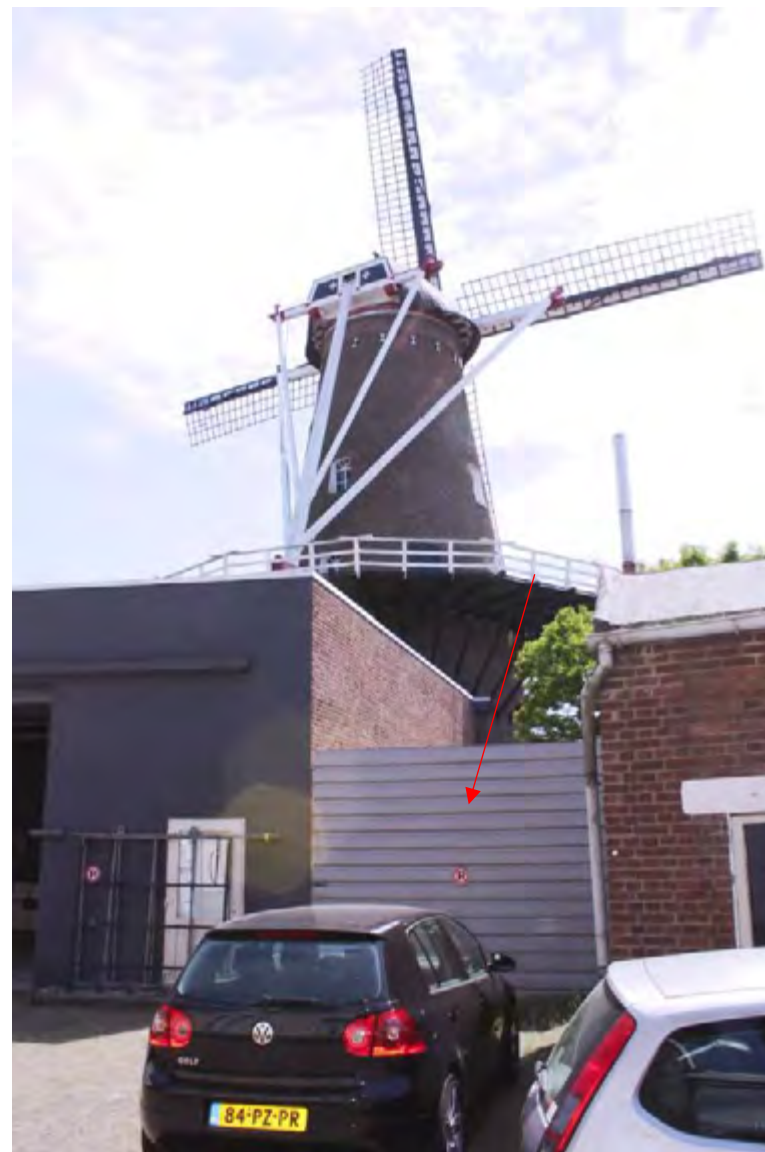
De omloop rondom de molen wordt aan de zijde van de Smalstraat afgesloten middels een bedrijfsdeur.
