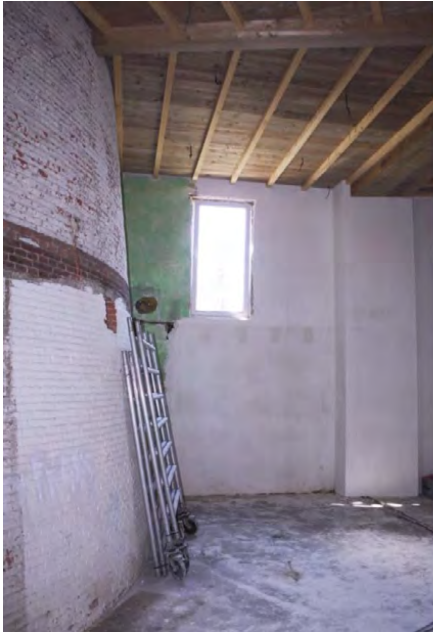
Zicht op de achtergevel van het fabrieksgedeelte uit 1928, gezien van binnenuit.
