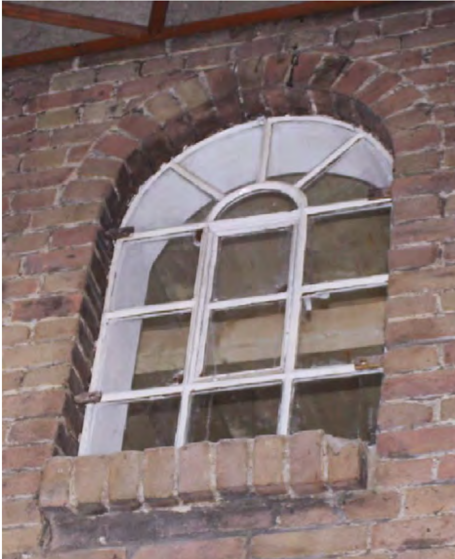
Detail van een van de originele vensters uit 1928 in de rechter gevel.
