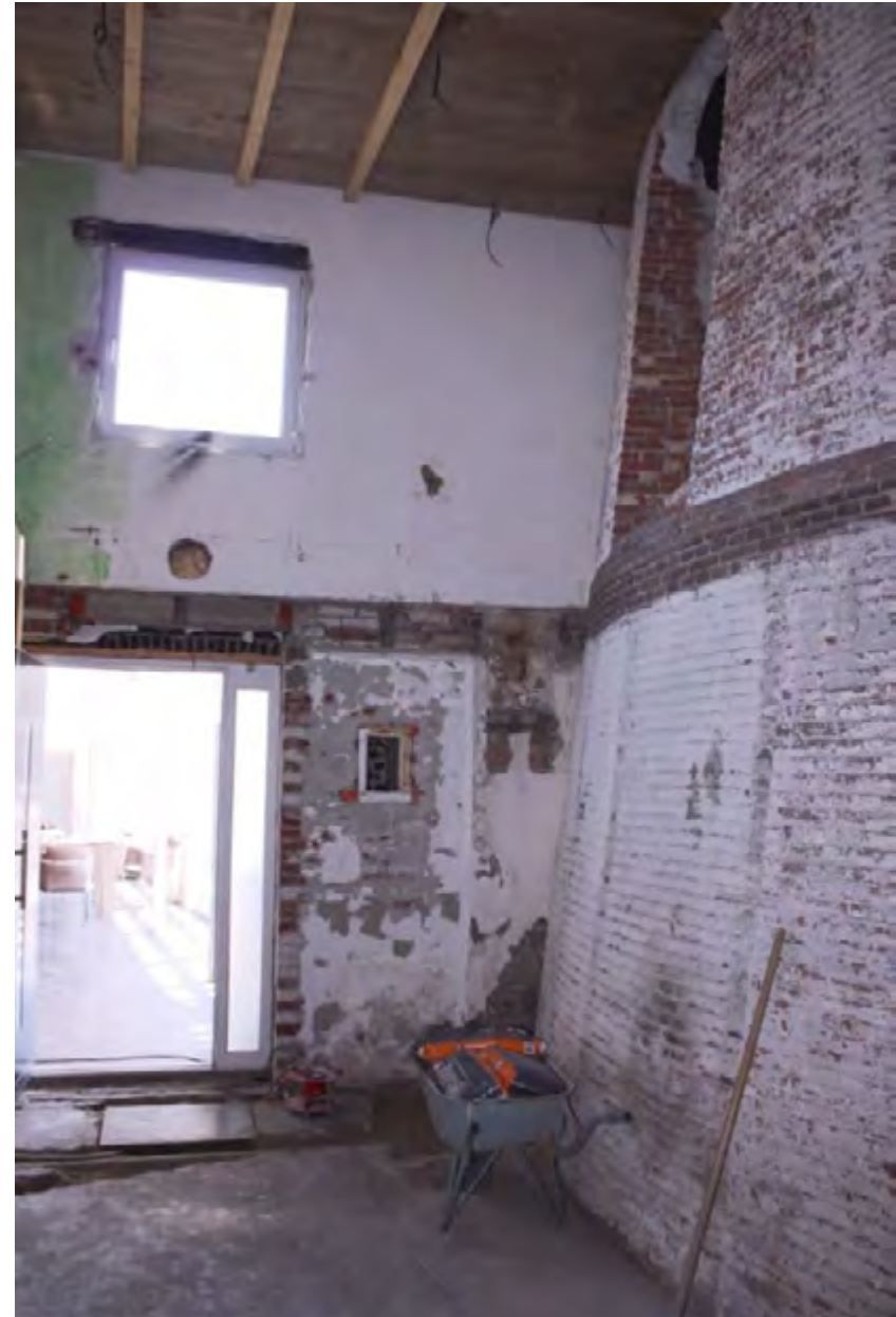
Zicht op de voorgevel van het fabrieksgedeelte uit 1928, gezien van binnenuit.
