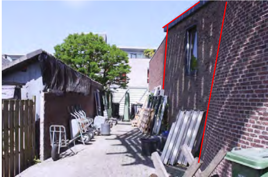
Zicht op de aansluiting aan de achterzijde van het fabrieksgedeelte uit 1928 tegen de molen (rode lijnen) en het deel uit 1962, links daarvan.
