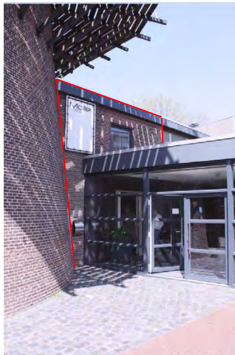
Zicht op de aansluiting aan de voorzijde van het fabrieksgedeelte uit 1928 tegen de molen (rode lijnen) en het deel uit 1962, rechts daarvan.
