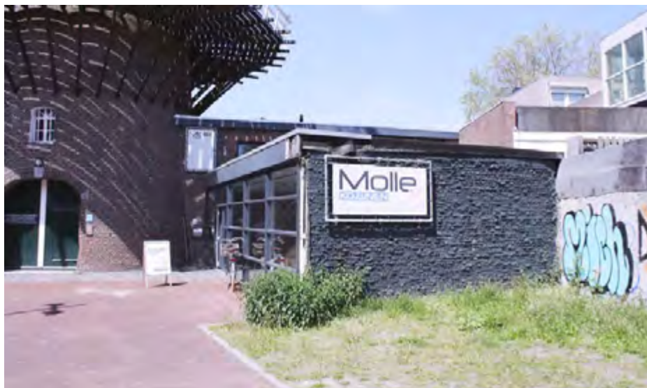
Zicht op het bouwdeel aan de voorzijde uit ca. 1990.
