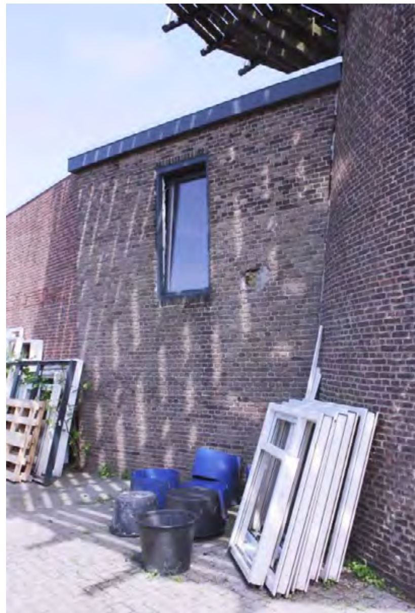
De achtergevel van het fabrieksgedeelte uit 1928 met het later aangebrachte raam.
