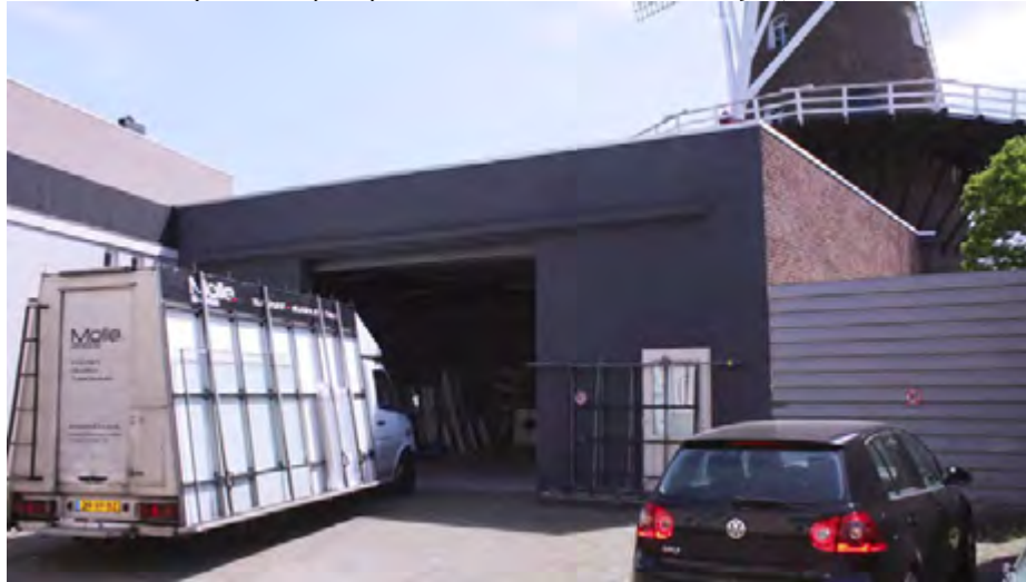
Zicht op de gevel uit 1962 aan de zijde van de Smalstraat.
